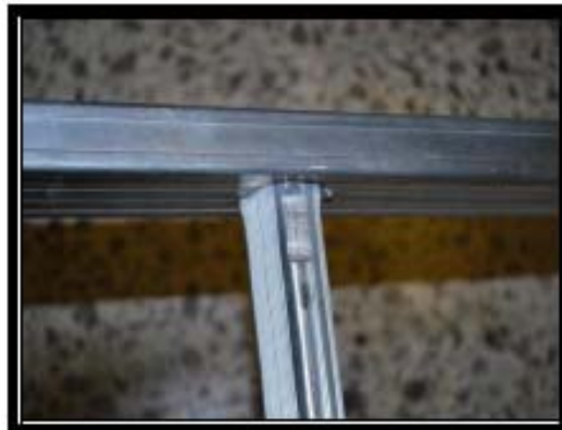
Peldaño en buenas condiciones por desgaste normal
