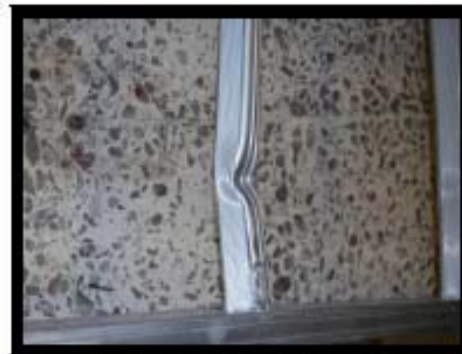
Golpe que no permite el buen funcionamiento de la escalera Cambiar escalera
